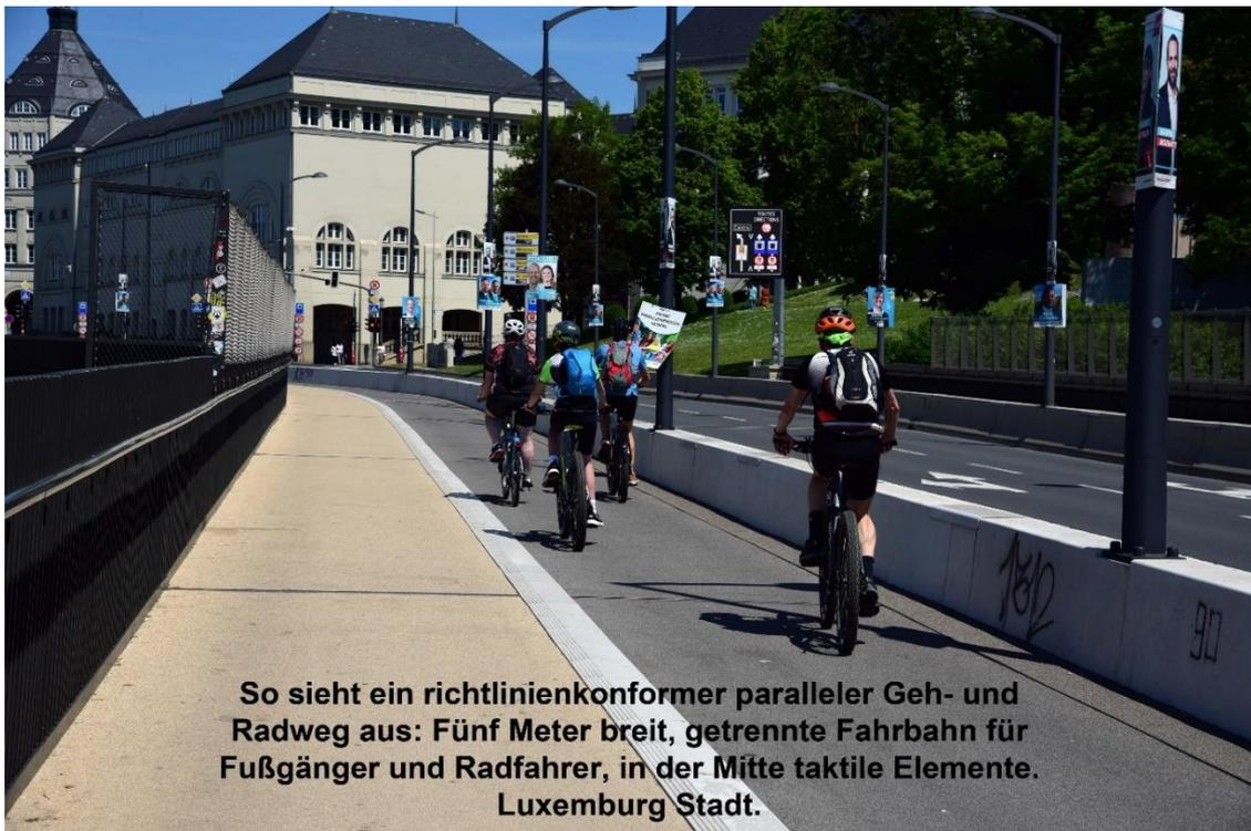
**So sieht ein richtlinienkonformer paralleler Geh- und Radweg aus: Fünf Meter breit, getrennte Fahrbahn für Fußgänger und Radfahrer, in der Mitte taktile Elemente. Luxemburg Stadt.**
