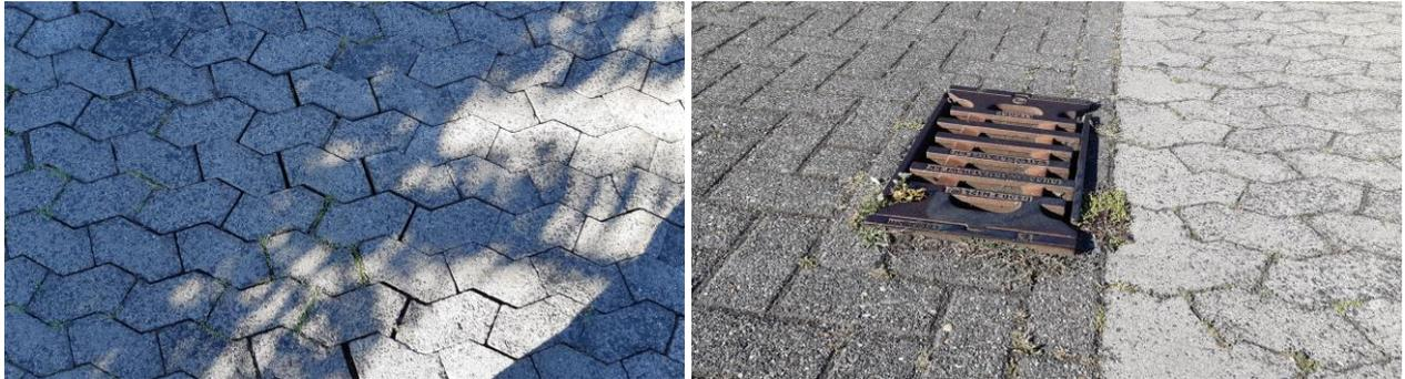
Abb. 2-2: Schäden im Bereich der vorhandenen Stellplätze (Lagerschäden, Setzungen)
