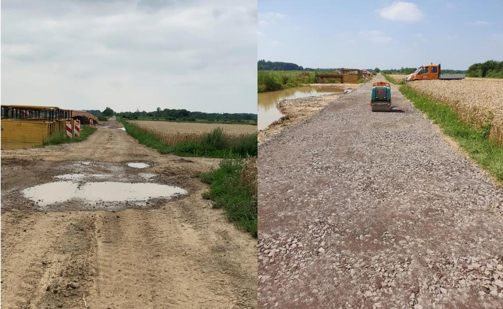
→ Zur Gewährleistung der Befahrbarkeit mussten ca. 10-15cm Schotter auf einer Länge von ca. 230m aufgebracht werden
