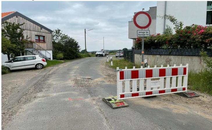
→ Sofortige Absicherung und provisorische Schließung mit losem Material und anschließender Schadensregulierung
