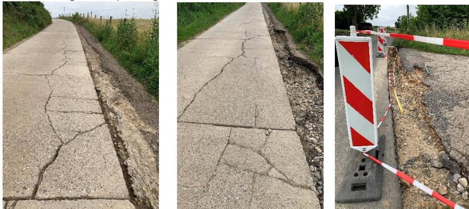
→ Sofortige Absicherung, prüfung der freiliegenden Leitung, Schadensregulierung
