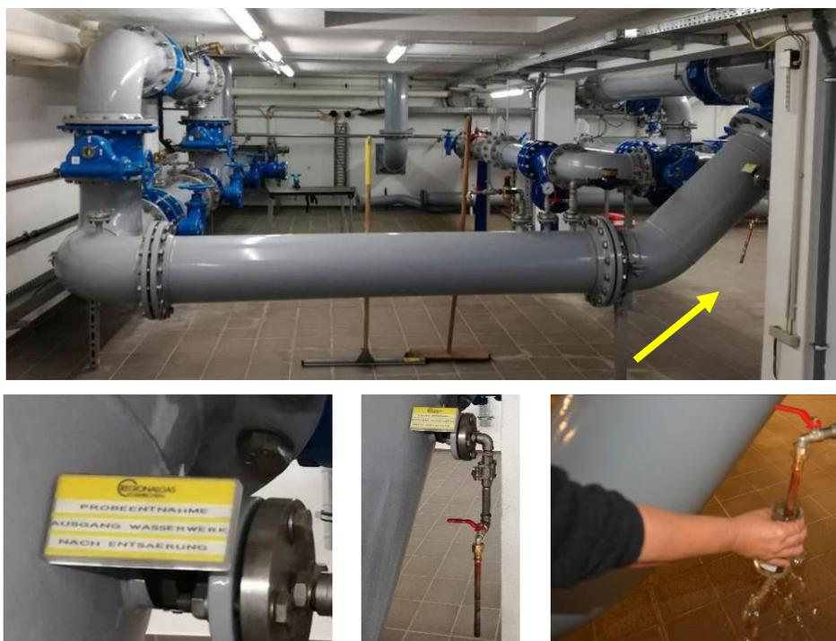
Abbildung 3: Probenahme im Wasserwerk Eichenkamp
