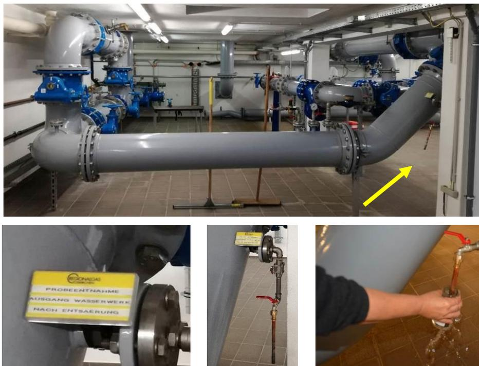
Abbildung 3: Probenahme im Wasserwerk Eichenkamp
