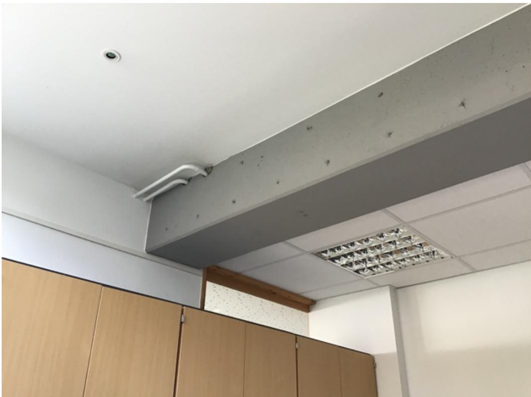
*Abbildung 8: Innenansicht – Ungedämmte Heizungsrohre durch Beton*
