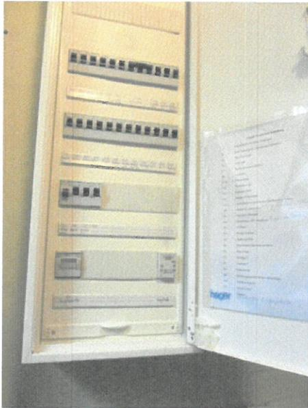
Bild 5, Unterverteiler Hauptgebäude
