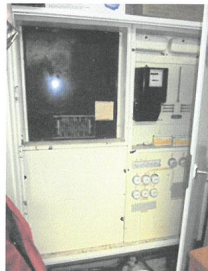
Bild 1, Zähler- und Hauptverteilung Hauptgebäude
