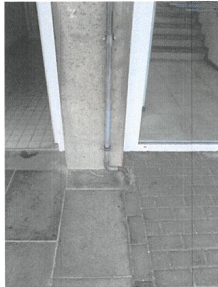
Bild 12, Telefon/EDV-Verbindungskabel
