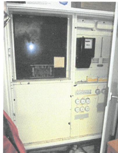
Bild 1, Zähler- und Hauptverteilung Hauptgebäude
