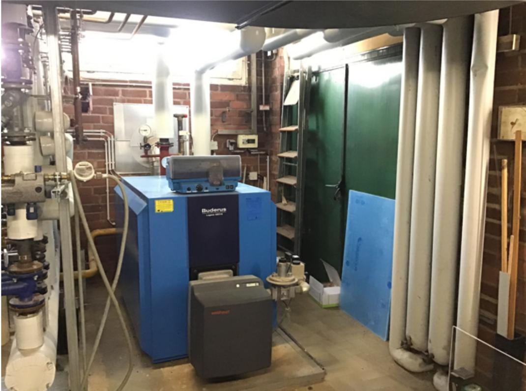
Abbildung 9: Wärmeezeuger - Buderus Kessel, Erdgas, Mod: GE315, 200 kW, Baujahr 2004
