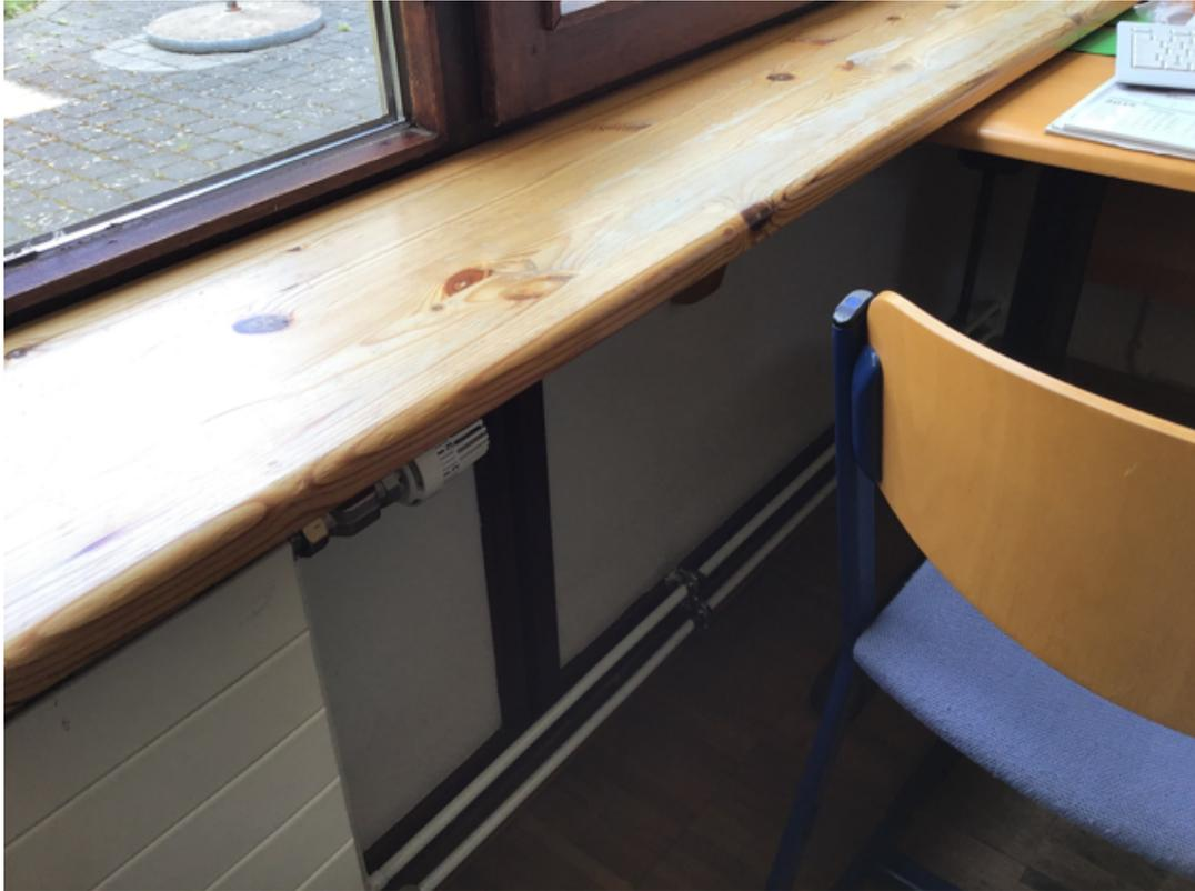
*Abbildung 7: Innenansicht – Ungedämmte Brüstungselemente im Verwaltungsriegel*
