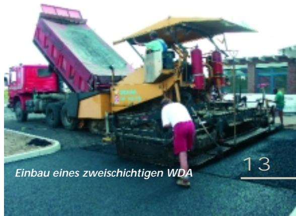
Einbau eines zweischichtigen WDA
