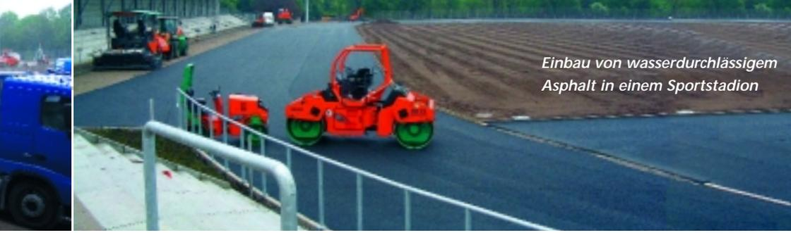
*Einbau von wasserdurchlässigem Asphalt in einem Sportstadion*
