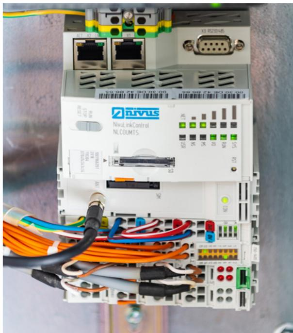
*Bild 3: Eine der Unterstationen: Der dezentral verbaute Controller steuert nicht nur die Prozesse, sondern überwacht gleichzeitig die Anlage.*
