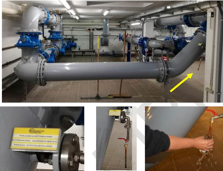
Abbildung 2: Probenahme im Wasserwerk Eichenkamp
