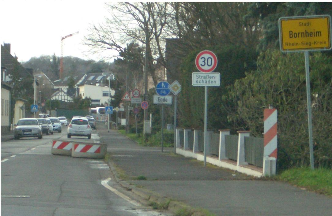
Eine Straßenbeleuchtung ist erst hinter der nächsten Straßeneinmündung "Zehnhoffstraße" vorhanden. Bei Dunkelheit und Blendwirkung durch Gegenverkehr besteht hier durch die Anordnung von Elementen zur Fahrbahneinengung eine erhebliche Unfallgefahr.
