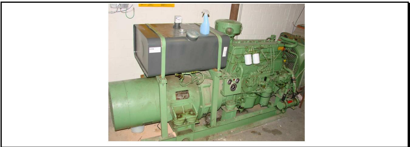
Das Notstromaggregat wurde errichtet, weil das Rathaus als Notfalllagezentrum im Krisenfall genutzt wird. Durch die Bereitstellung eines mit einer Batterie gepufferten USV-Stromkreises für die wichtigsten elektrischen Anwendungen sind nach Aussage der städtischen Vertreter die Anforderungen an das Notstromaggregat hinsichtlich Anlaufsicherheit offenbar nicht ganz so hoch
