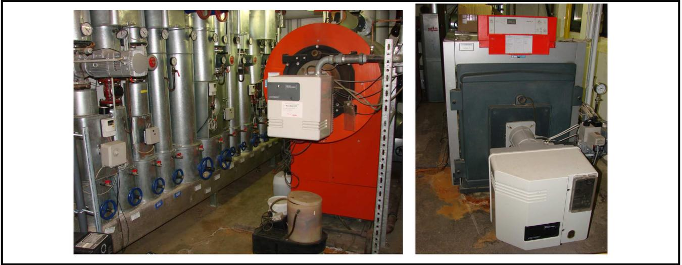
Die beiden Kessel und der Heizkreisverteiler sind auf den nachfolgenden Fotos zu sehen. Der linke Brennwertkessel ist inzwischen defekt. Der noch in Betrieb befindliche Niedertemperaturkessel kann zwar zur Zeit die komplette Beheizung übernehmen. Die Sicherheit der Wärmeversorgung ist allerdings eingeschränkt und der Jahresnutzungsgrad ist auch deutlich höher als bei einem Brennwertkessel.
