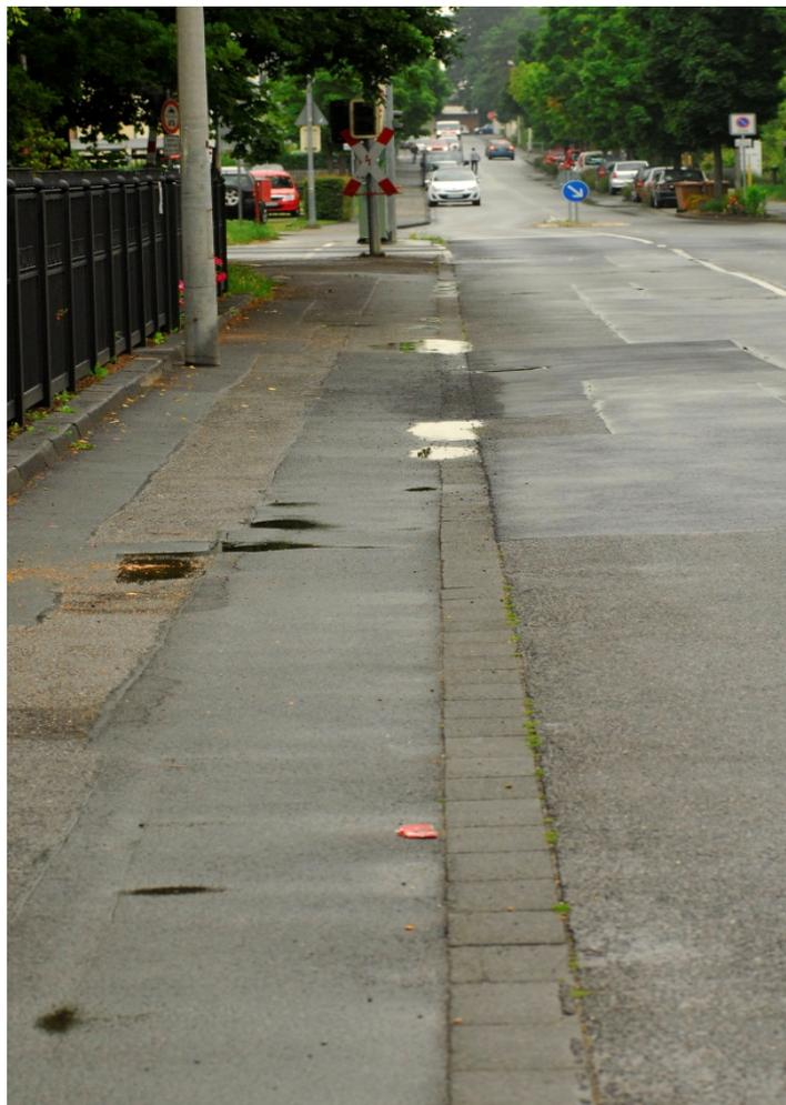
**So soll der „Gehweg“, nach der Kanalbaumaßnahme, wieder hergestellt werden. Ohne Trennung mittels Bordstein von der Fahrbahn**
