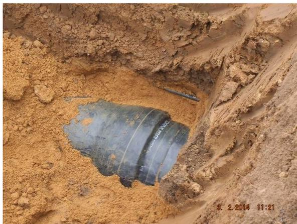
**Abbildung 6:** zur Inspektion freigelegte Leitung
