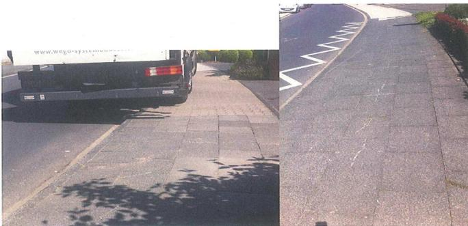
Hier sind keine Wurzelverdickungen feststellbar. Platten teilweise gebrochen, aber keine Unfallgefahr.
