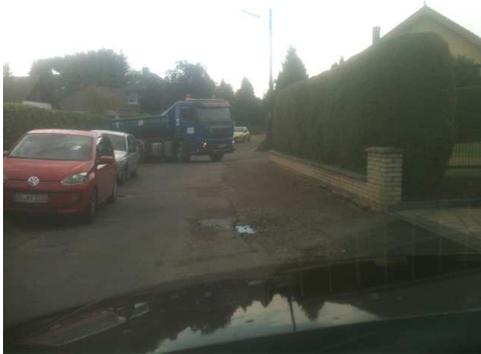
Der Randbereich für Haus 14 (unbefestigt) wird mit Vauatol ausgebessert. Durch LKW-Verkehr jedoch keine dauerhaft Lösung.
