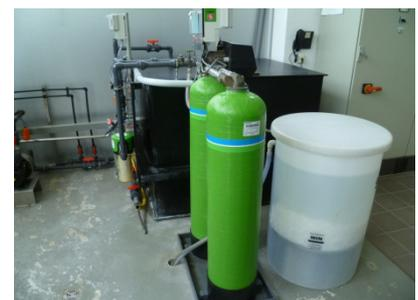
Das Weichwasser wird mit zwei Weichwasserpumpen zur Dosierstelle gefördert. Deren Förderleistung beträgt laut Typenschild bis zu 3 m<sup>3</sup>/h, die tatsächliche Förderung liegt aufgrund der druckseitigen Widerstände in den Dosierlanzen geschätzt zwischen 0,8 - 1,5 m<sup>3</sup>/h. Die Weichwasserpumpen werden gemäß automatischer Steuerung wechselweise betrieben
