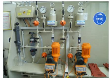
Vor der Dosierung wird die Natronlauge mit enthärtetem Weichwasser verdünnt. Zu diesem Zweck wird eine Weichwasser-Anlage mittels Ionentauscher betrieben, welche einen Vorlagebehälter für Weichwasser speist. Das Volumen des Vorlagebehälters beträgt etwa 1 m<sup>3</sup>. Die Steuerung erfolgt über eine Höhenstandsmessung innerhalb des Vorlagebehälters.
