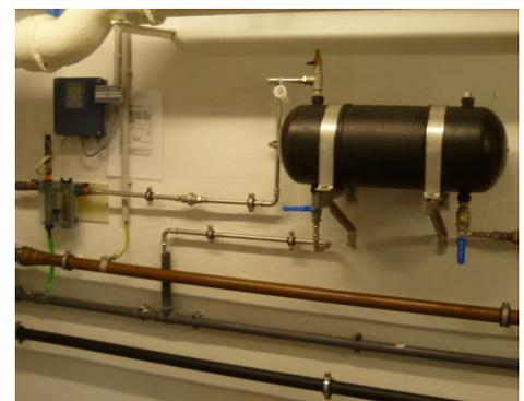
Die Steuerung der Natronlauge dosierung erfolgt gemäß der Anlagen- und Funktionsbeschreibung mengenproportional, Führungsgröße ist die Summe der Messwerte der Zulaufmengen der beiden Vorlieferanten. Auf dieses Signal ist eine Regelung des im Trinkwasser gemessenen pH-Wertes aufgeschaltet.
