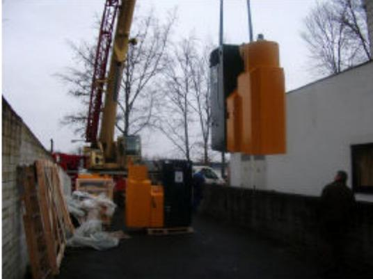
Die drei Pelletkessel werden per Kran in den Keller transportiert.....
